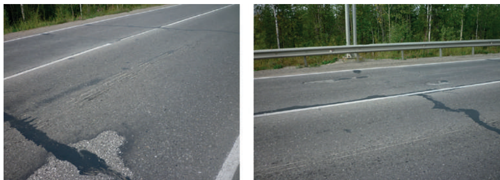
Рис. 2. Механическое воздействие на элементы АПВГК в результате выполнения работ по сезонному содержанию
