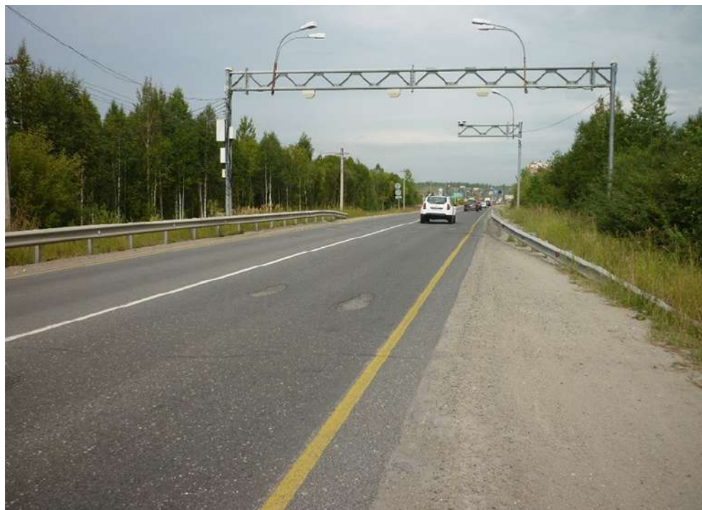
Рис. 4. Критический износ поверхности покрытия наблюдается в зонах торможения транспортных средств перед АПВГК
