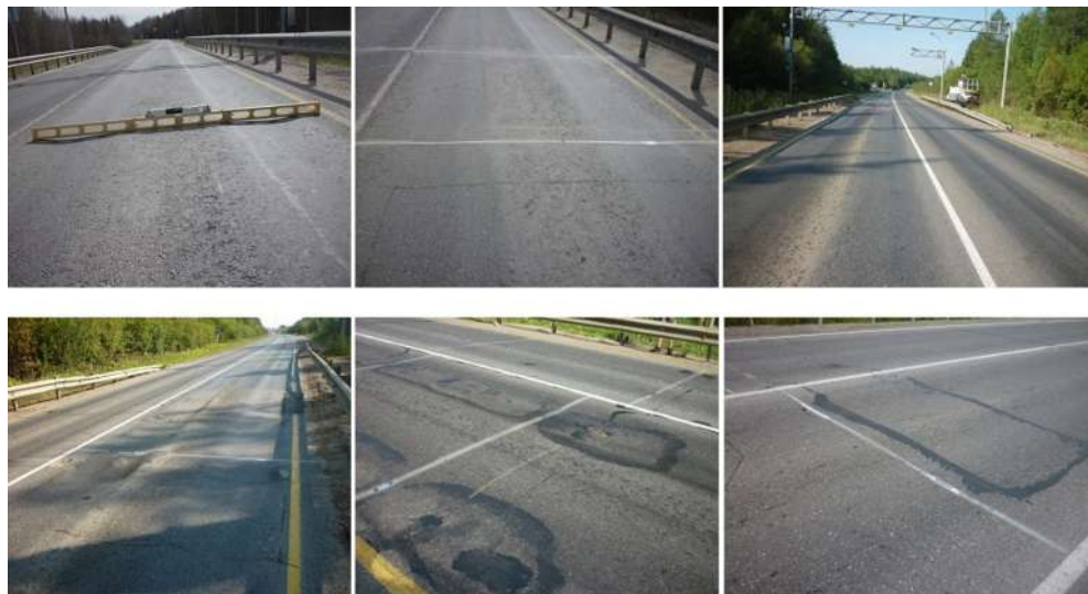
Рис. 1. Колейность в зоне АПВГК
